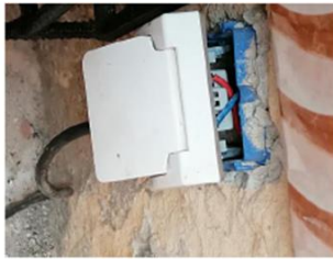
Prise de courant mal fixée sous tension présentant un risque de contact direct
