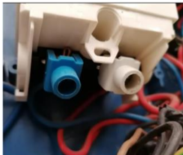
Connexion non fiable 2,5mm 2 en sortie DB (pt 41)
