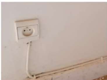
Mélange des fonctions(PC + moteur surpresseur) sur le même circuit (pt 34)
