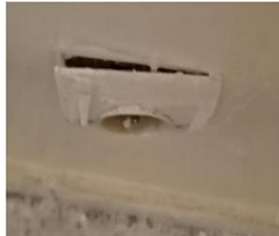
Prise de courant mal fixée sous tension présentant un risque de contact direct
