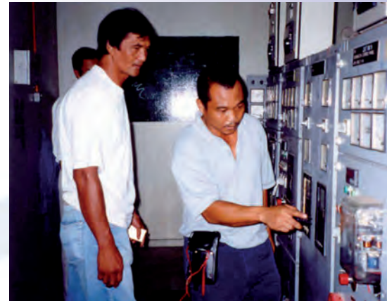
"Una persona competente" inspeccionando un relé de protección en un tablero de mando general.
